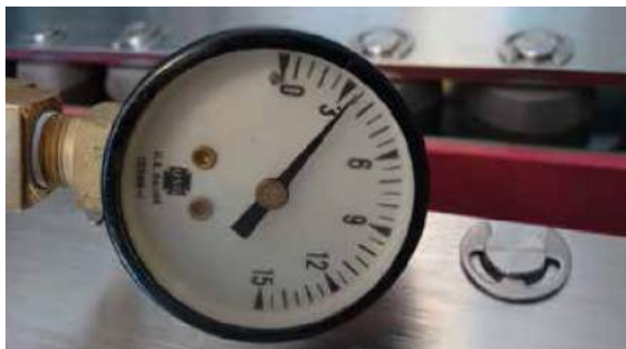
Misuratore indicante la pressione interna minima durante l'ispezione.
